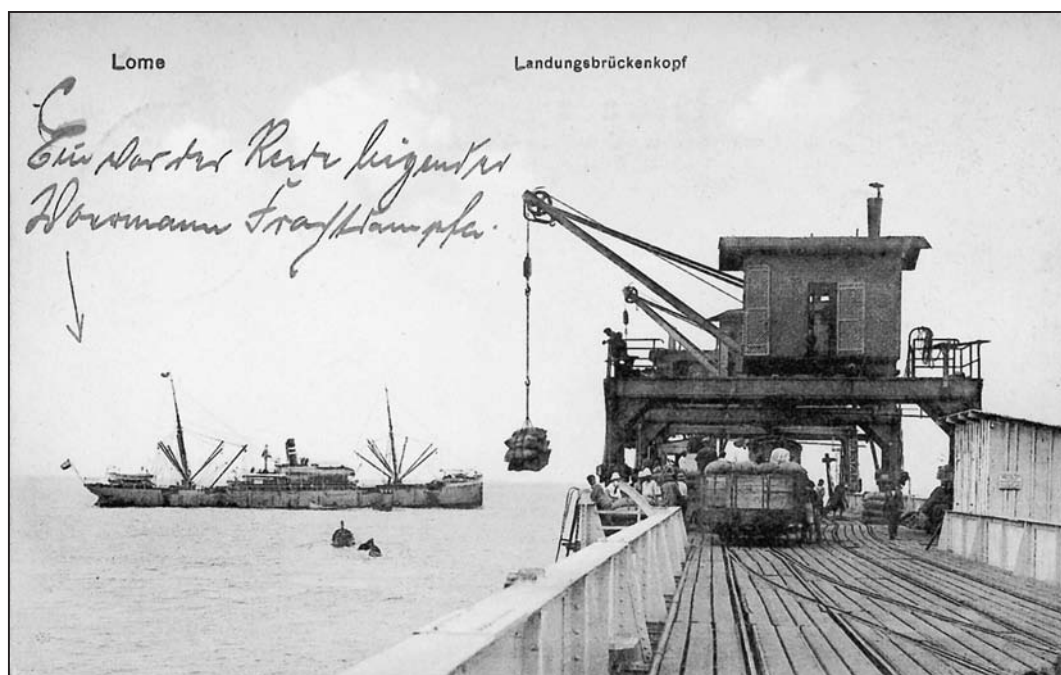
Abbildung 7: Dampfkran (bis 6t Ladefähigkeit) am Brückenkopf
