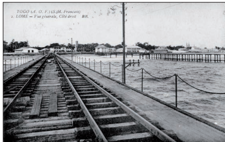
Abbildung 16: Die von der französischen Mandatsregierung erbaute neue Landungsbrücke mit acht Dampfkränen – etwa 100m länger als die 1928 zerstörte alte deutsche Brücke.
