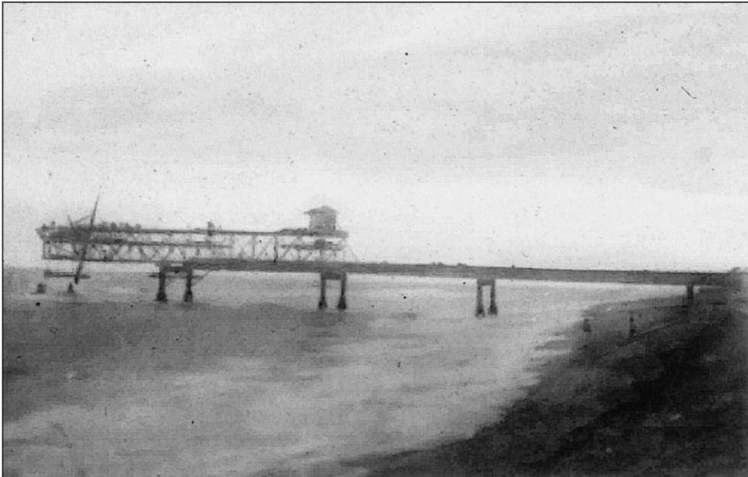
Abbildung 4: Die Landungsbrücke im Bau (1903)
