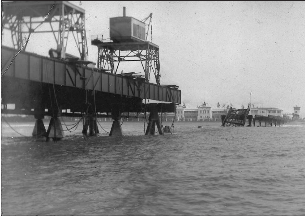
Abbildung 13: Die zerstörte Landungsbrücke – Aufnahme von der Seeseite
