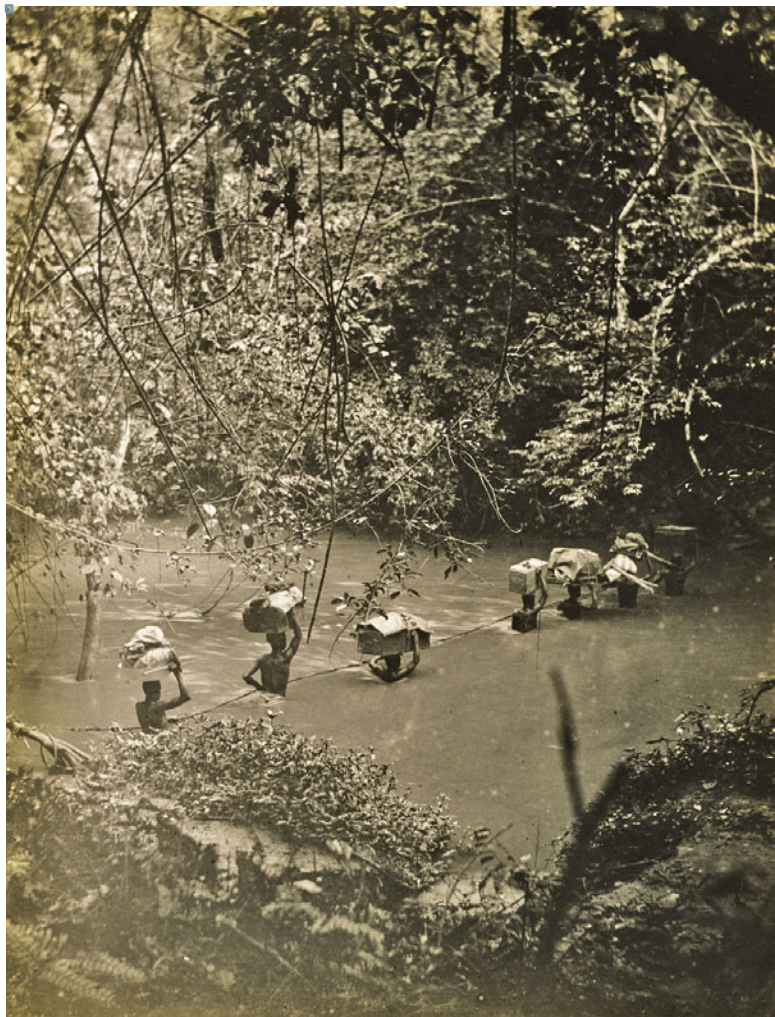
Abb. 42: Warentransport vor Straßen- und Brückenbau
