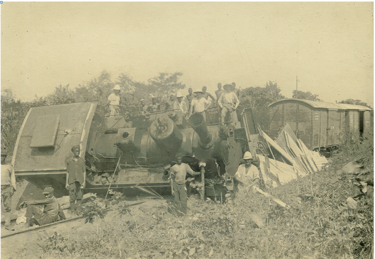
Abb. 21: entgleiste Lokomotive während des Bahnbaus
