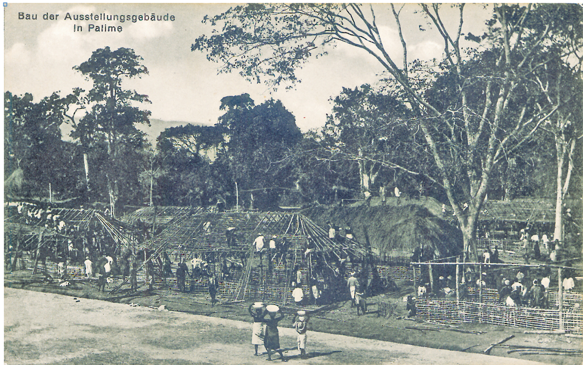
Abb. 51: Aufbau der Ausstellungsgebäude in einheimischer Bauweise
