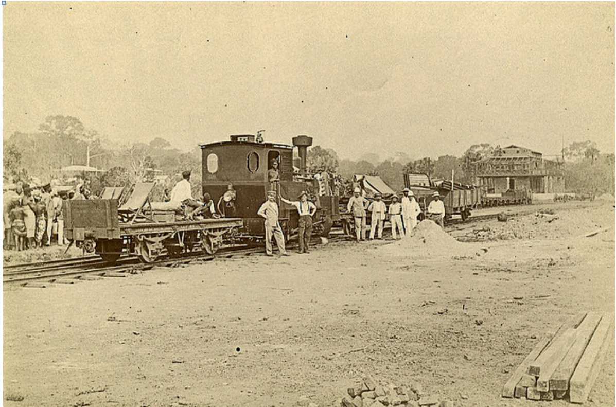
Abb. 30: Arbeiten am Bahnhof Palime – zwei Tage vor Eröffnung
