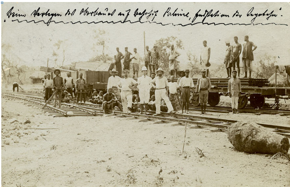
Abb. 31: Foto-Ansichtskarte vom Bahningenieur Hermann Gottwald „Beim Verlegen des Oberbaus auf Bahnhof Palime, Endstation der Togobahn“
