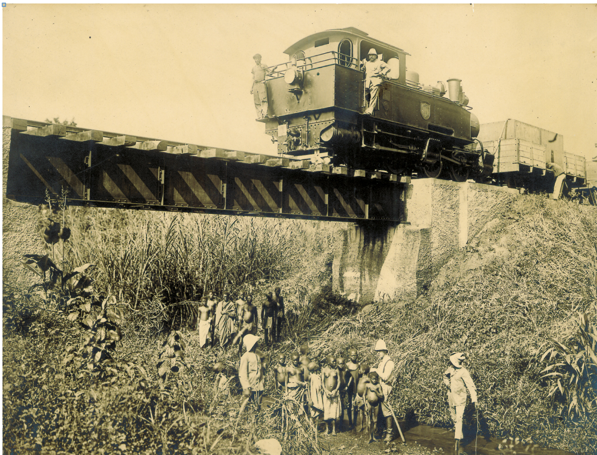
Abb. 23: Brücke km 94 bei Gadja
