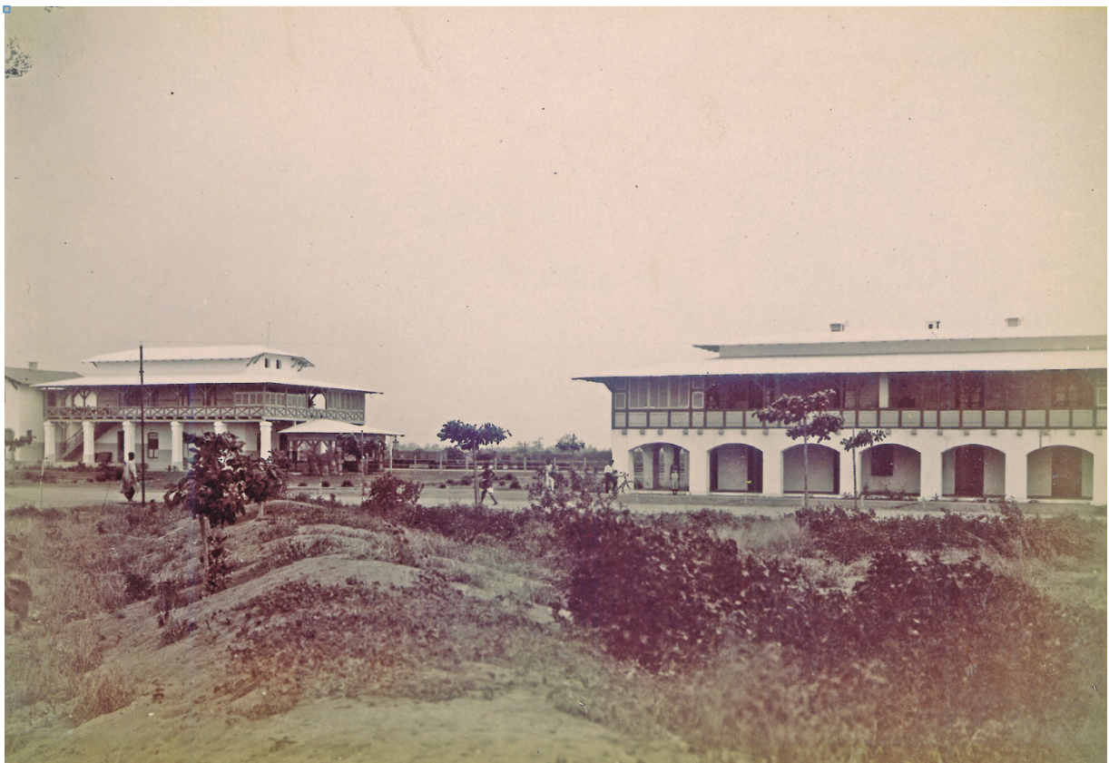
Abb. 4: die Eisenbahndirektion und das Wohnhaus der Bahnbeamten in Lome
