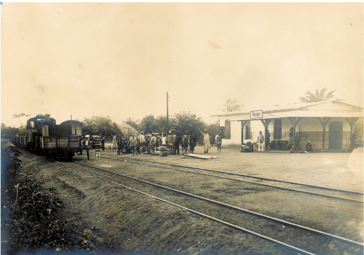
Abb 12 : Bahnhof Noepe (Aufnahme in Richtung Lome), km 22
