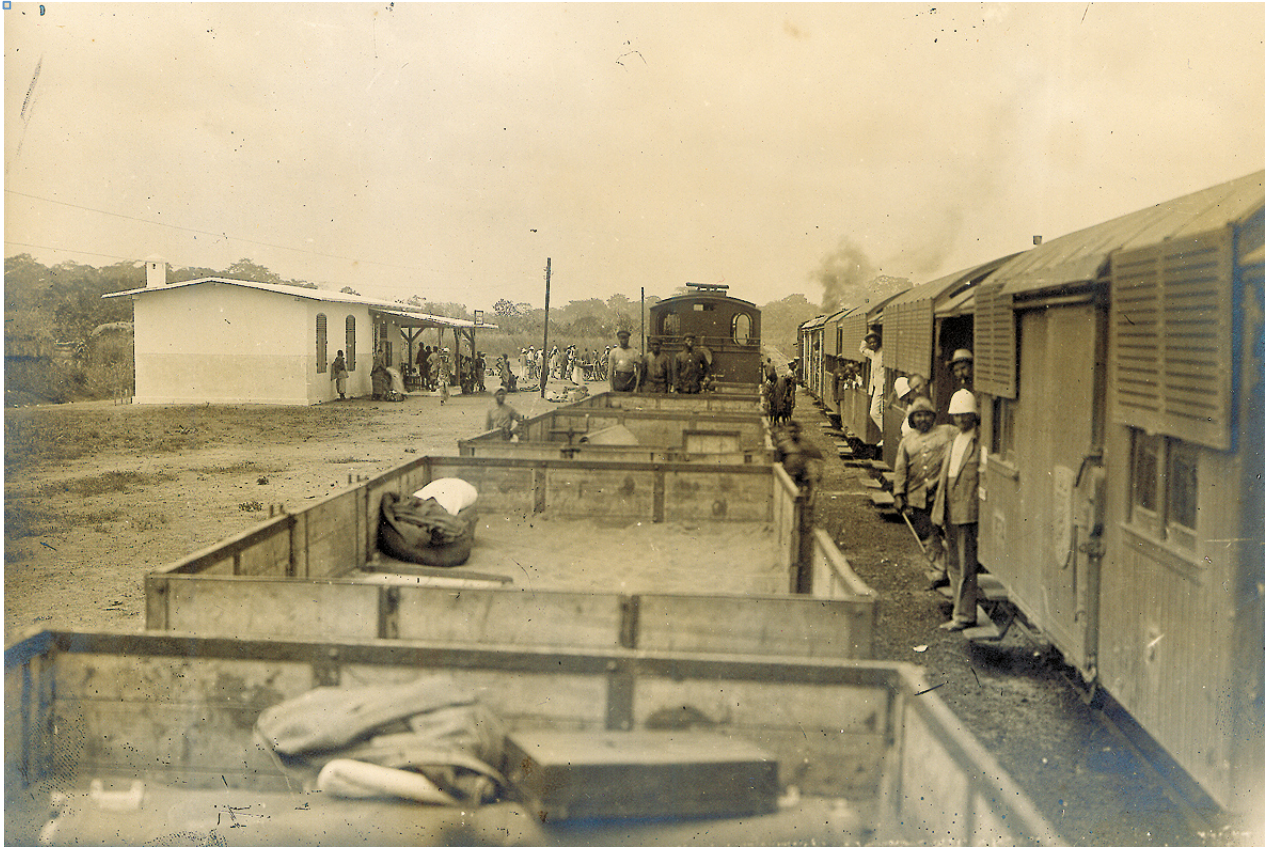
Abb. 11 : Bauzug und Personenzug am Bahnhof Noepe 1906 (in Richtung Palime)
